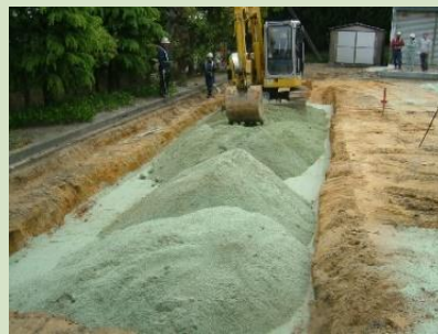
図8 雨水貯留槽としての利用
