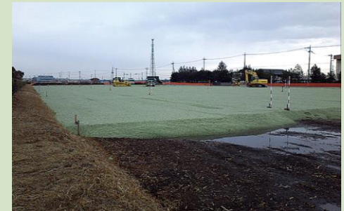
図23 サンドマット施工事例
