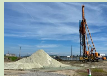
図20 ゼロメートル地帯広域防災拠点整備工事施工
