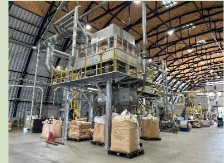
図22 プラスチックリサイクル工場設備
